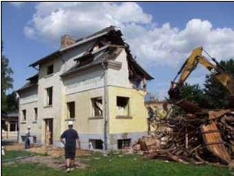
(Foto: Abriss des alten Gebäudes)
