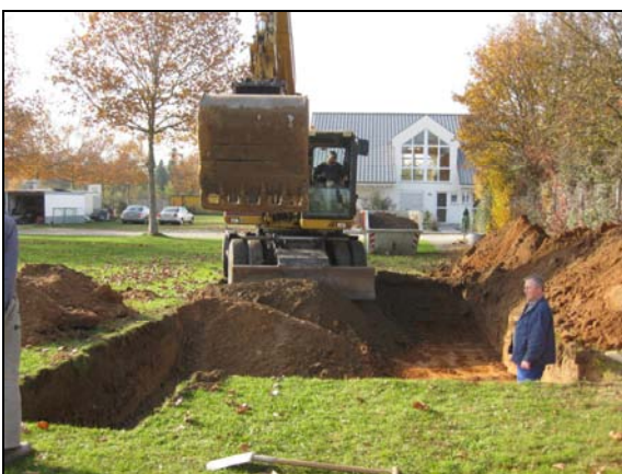
(Foto: Ausbaggern der Baugrube für die Kneipp-Anlage)
