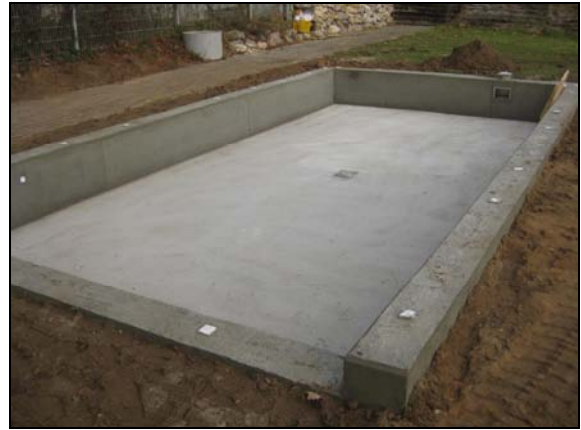
(Foto: Rohbau des Kneipp-Beckens)
