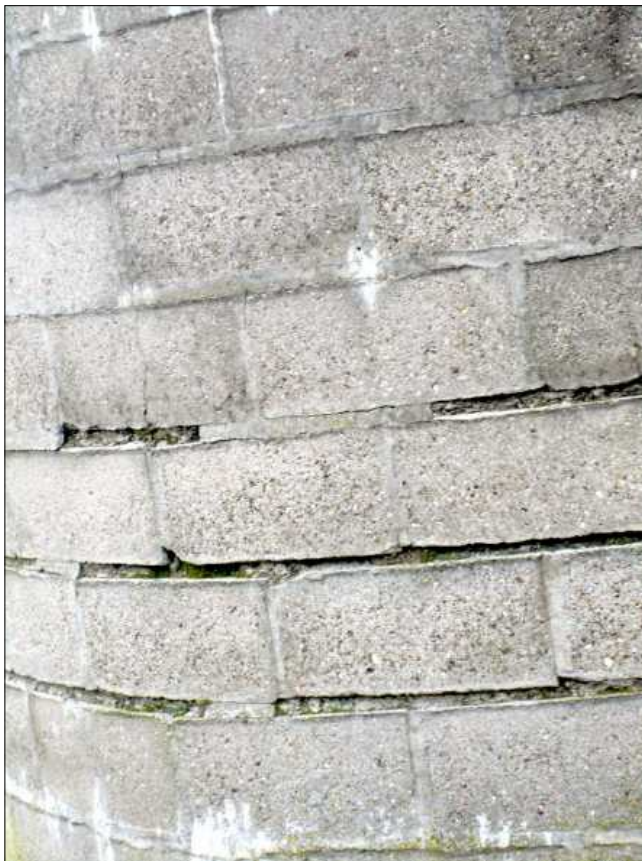
Foto 2: Detail der Außenwand mit Fugen und Ritzen. 23.03.18-HGF
