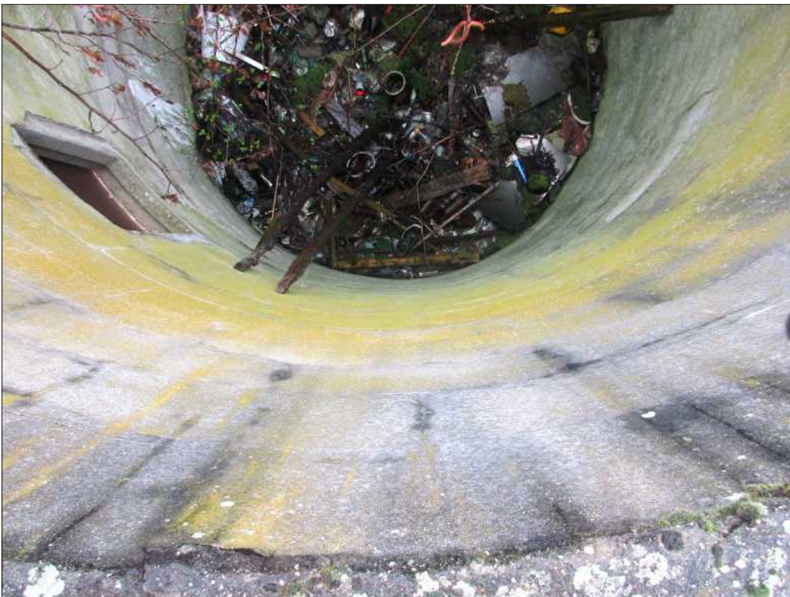
Foto 3: Innenansicht mit seitlicher Metallklappe, Vermüllung und Leiterchen. Auffallend die glatten, fugenlosen Wände. 23.03.18-HGF
