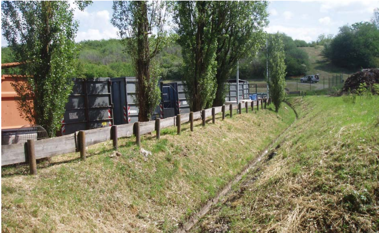
Versickerungsgraben auf der nördlichen Seite des Wertstoffhofs kurz nach Durchführung der Pflegemaßnahmen (Mai 2020)
