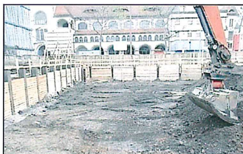
Abb. 4. Schichtenweiser Abtrag, verpflichtend bei baubegleitender KMR
