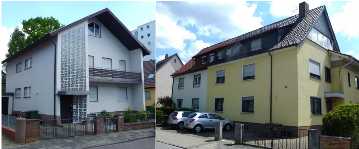
Abb. 7: Typische Gebäude mit mittlerem energetischem Einsparpotential im UG. (Quelle: Fotodokumentation)
