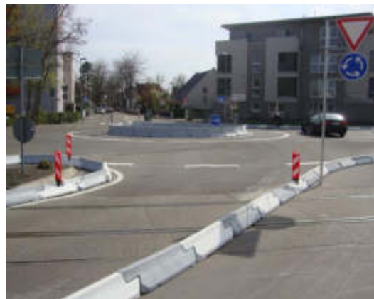
Abbildung 7: Radverkehrsführung auf der Fahrbahn. Provisorischer Kreisverkehr (Friedrich-Ebert-Straße - August-Bebel-Straße). (Aufnahme: Stadt Viernheim)
