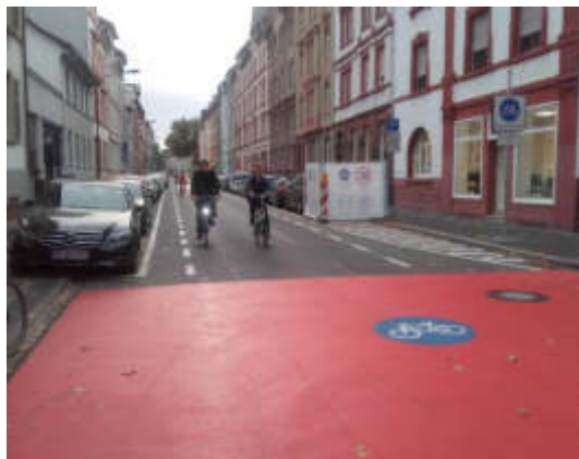
Abbildung 10: Gut sichtbare Fahrradstraße in Offenbach
