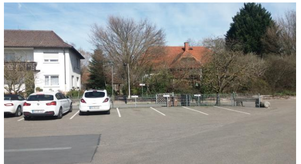
Wohngebäude 25A und 25B
