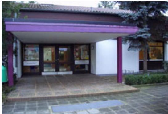
Eingangsbereich Kiga Pirmasenser Str.
