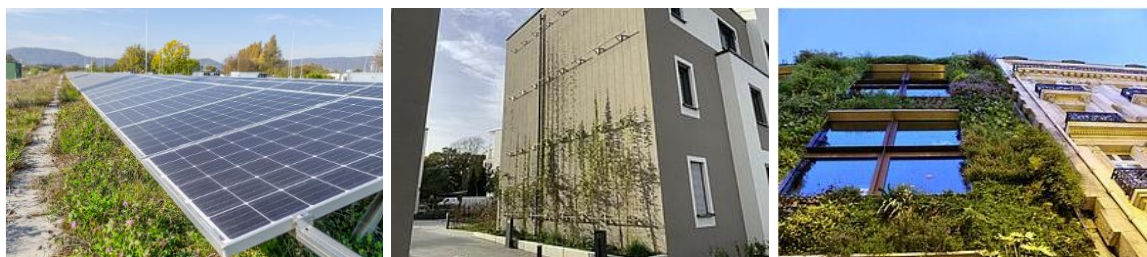
Abbildung 33: extensive Dachbegrünung, boden- und wandgebundene Fassadenbegrünung (Quelle: https://www.hlnug.de/stadtgruen-im-klimawandel/bauwerks-begrueung-aussuchen )
